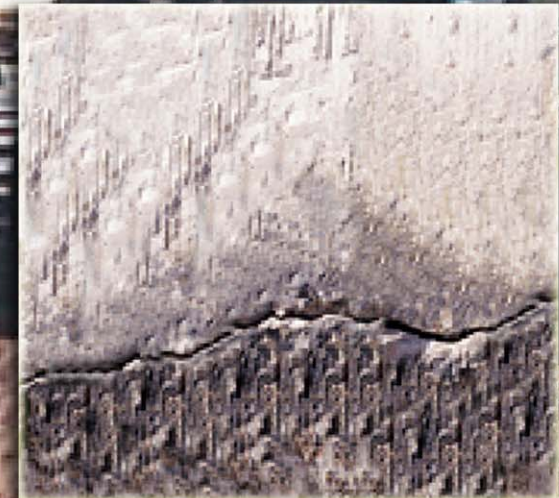
Uma das trincas após a limpeza.
