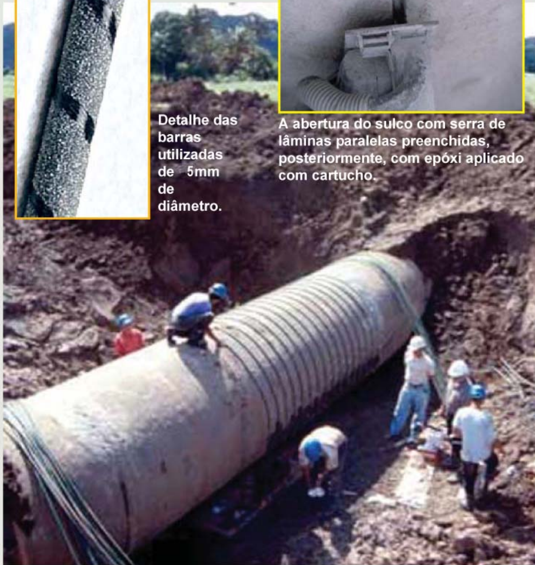
O reforço estrutural com barras de fibra de carbono, anterior à instalação dos anodos de sacrifício.
