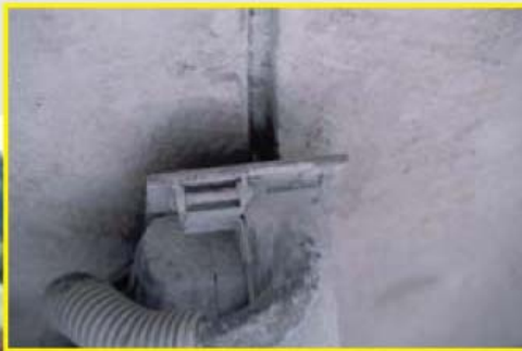
A abertura do sulco com serra de lâminas paralelas preenchidas, posteriormente, com epóxi aplicado com cartucho.
