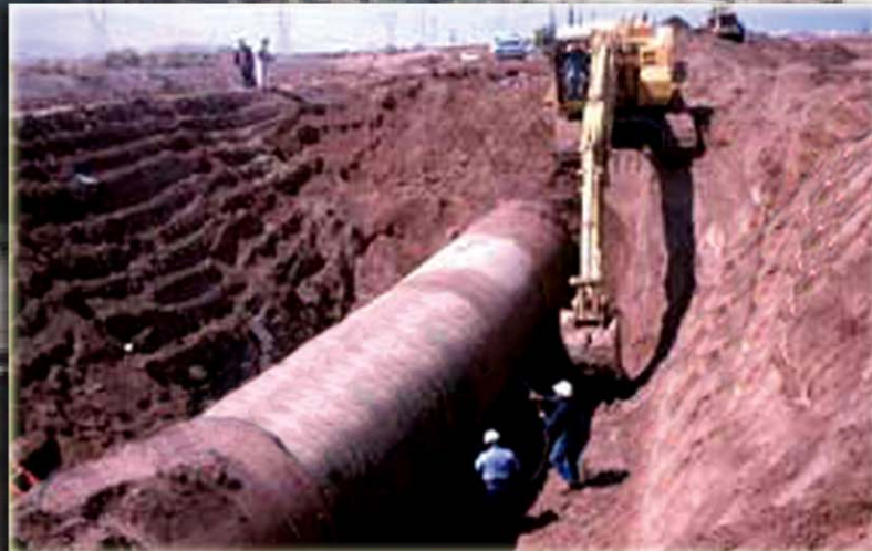
Escavação em um trecho comprometido.
