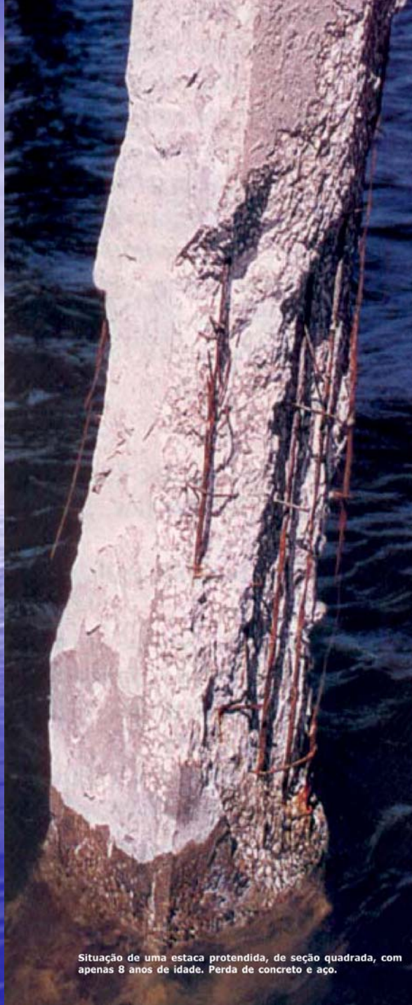
Figura 1 - Zonas de corrosão nas estacas e a perda relativa da seção do aço para revestimentos metálicos e armaduras de concreto comportamento diferenciado para jaquetas metálicas e superfícies de concreto armado/protendido.
