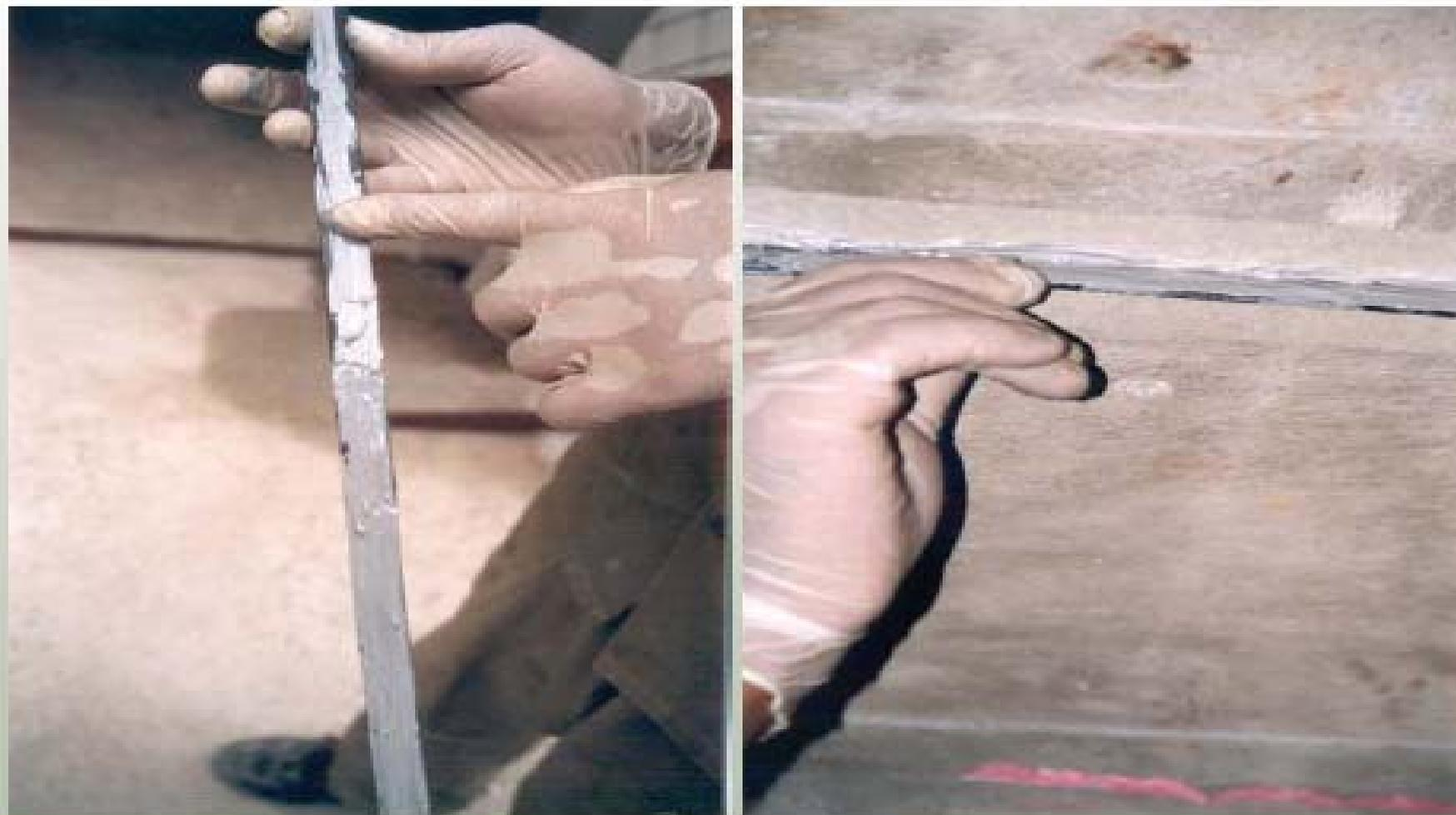
Figura 1 e 2 - A fita de fibra de carbono sendo inserida no sulco previamente preenchido com epóxi. A aplicação do epóxi estruturante em ambos os lados da fita antes de sua inserção no sulco.
