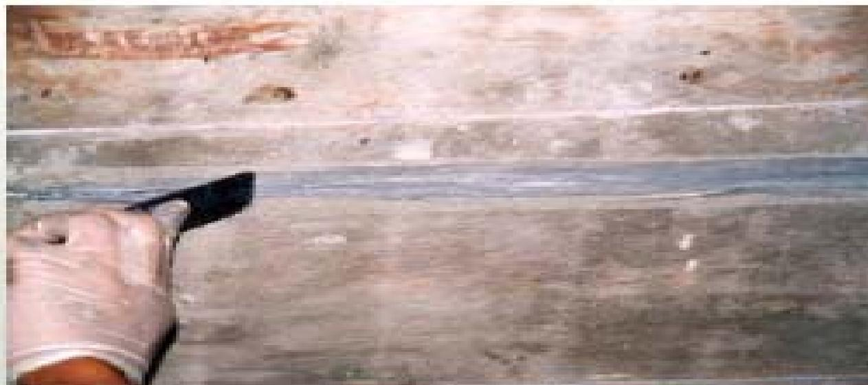
Figura 7 - A aplicação complementar de epóxi estruturante, com espátula, para nivelamento do sulco já com a fita de reforço.
